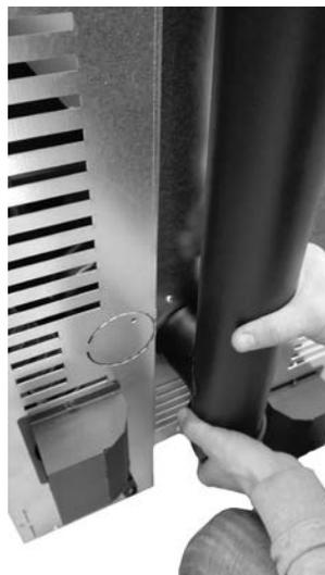
**Fig. 55 - Insert pipe d.80 mm**
